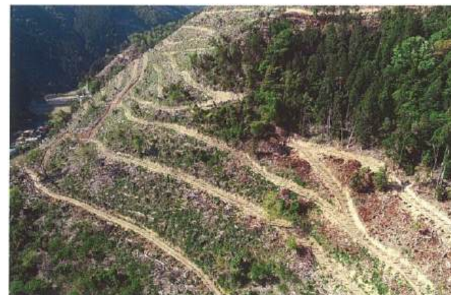
跡地造林（原地区）：施工後
