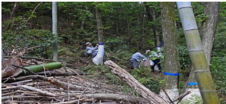
(市民ボランティアによる伐採実施状況)
