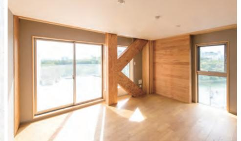
リブウッド大阪城は、大阪城を望む立地に建つ低層1～3階を鉄骨造、上階4～8階を純木造とした地上8階建て混構造の建物です。施主でもあるオリオン建設が、経験豊富な木造ファブリケーターと協働することで、大手ゼネコンではなく地域工務店主導で中大規模木造建築を実現しました。
