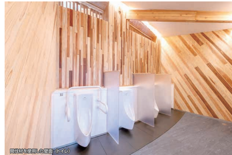
間伐材を使用した壁面（トイレ）
