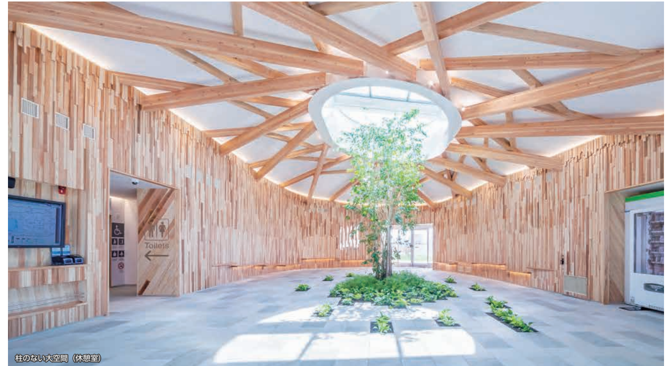
柱のない大空間（休憩室）
