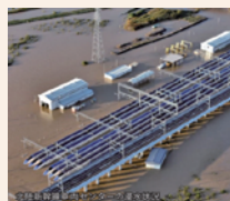
北陸新幹線の水没状況 / 令和元年東日本台風、北陸地方整備局管内の被害記録より
