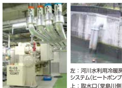
左: 河川水利用冷暖房システム(ヒートポンプ) 上: 取水口(堂島川側)
