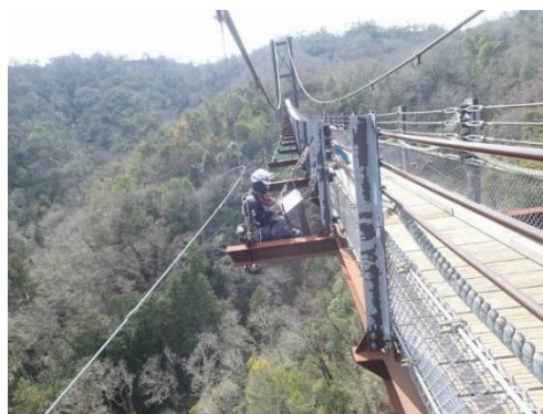
専門業者による吊り橋点検作業
