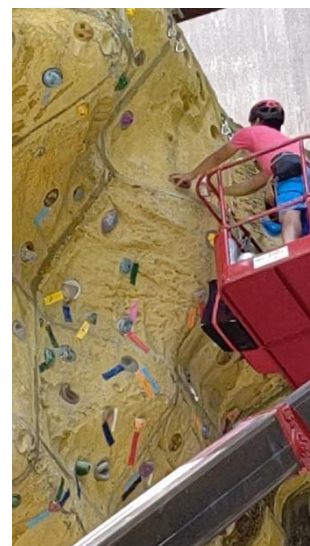
ホールド交換作業
