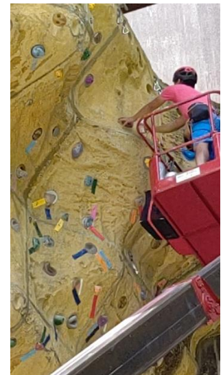
ホールド交換作業
