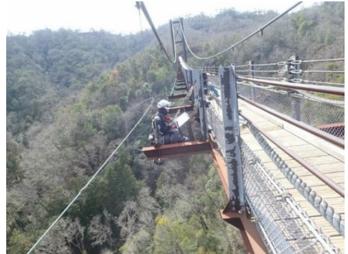
専門業者による吊り橋点検作業
