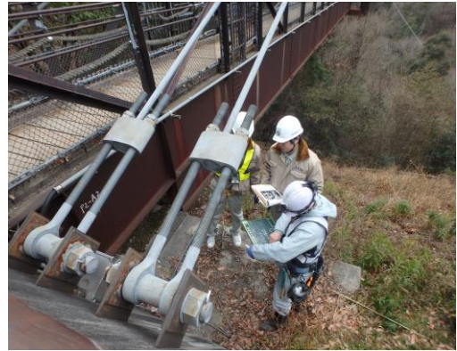
（専門業者による吊り橋点検作業）
