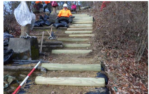
（園路階段の補修）
